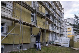
Trabajadores instalan aislamiento térmico de lana mineral amarilla en la fachada de un edi
