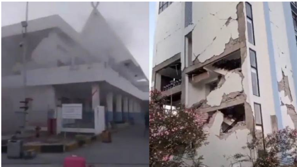
Edificios dañados y derrumbes tras terremoto en Indonesia con alerta de tsunami
