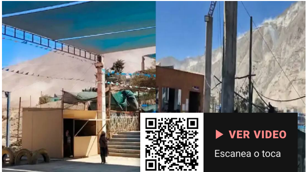
Escuelas e infraestructuras en zonas montañosas de Perú con daños por sismo de magnitud 7.
