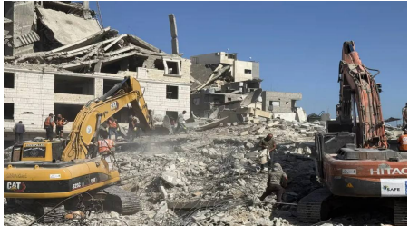
Maquinaria pesada remueve escombros de edificios destruidos en Gaza mientras equipos de re
