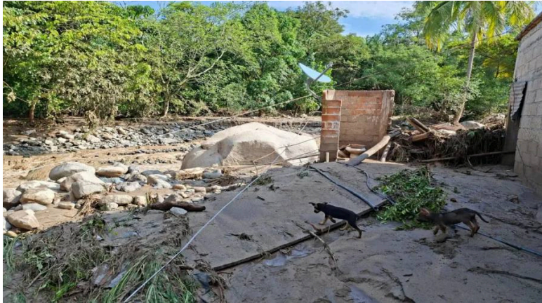
Daños en vivienda tras colapso por lluvias en Jalisco, con escombros y materiales disperso
