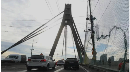
Puente cubierto con malla de protección contra drones, con vehículos circulando bajo su es
